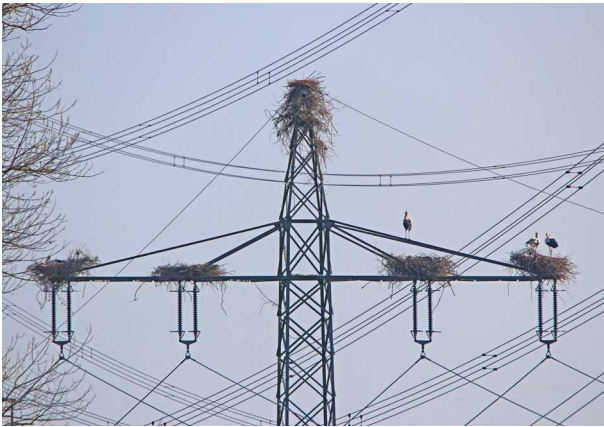
Abbildung 1: Freileitung an der Radenhäuser Lache, Foto: W. Kräling
