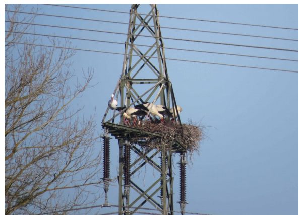
Abbildung 2: Freileitung an der Radenhäuser Lache, Foto: W. Kräling
